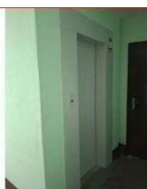
Фото: Вид подъезда (вход)
