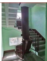
Фото: Вид лестничной клетки
